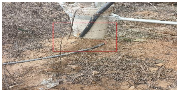
直流电缆未穿保护套管
