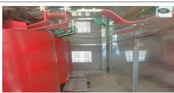
箱变低压侧电缆地线一点多线
