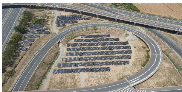
某高速匝道圈光伏
