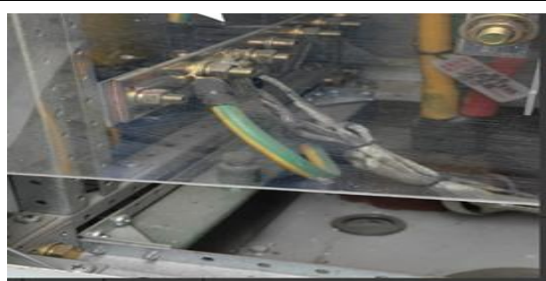
箱变低压侧电缆地线一点多线
